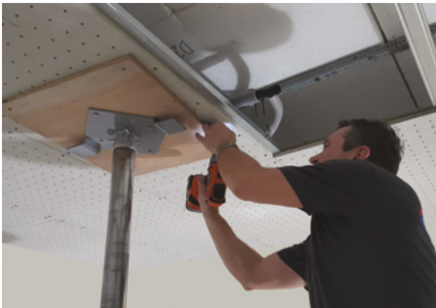
Montaż paneli sufitowych Assembly heating - cooling panels
