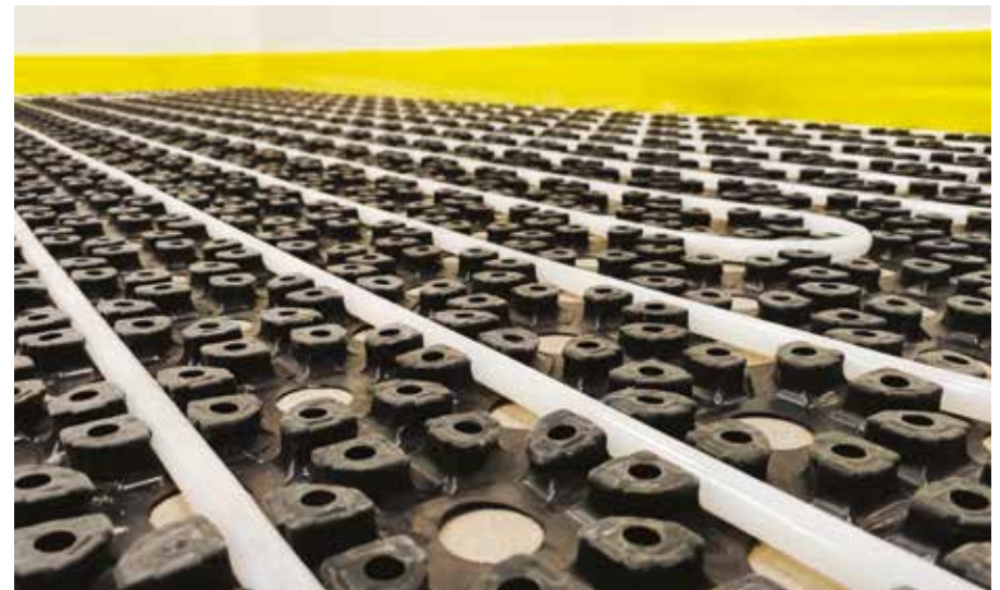
Befestigung des Fußbodenheizungsrohrs in der Eurorenova-Matte Fastening underfloor heating pipe in Eurorenova castellated mat
