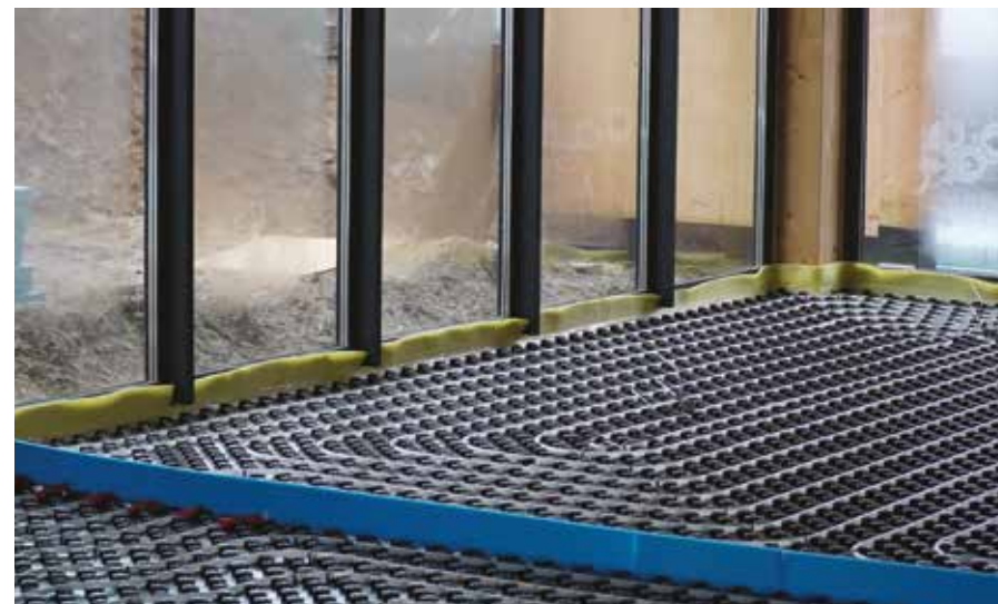
Verlegung einer Fußbodenheizung mit Eurotop-Matte Underfloor heating installation with usage of Eurotop castellated mat
