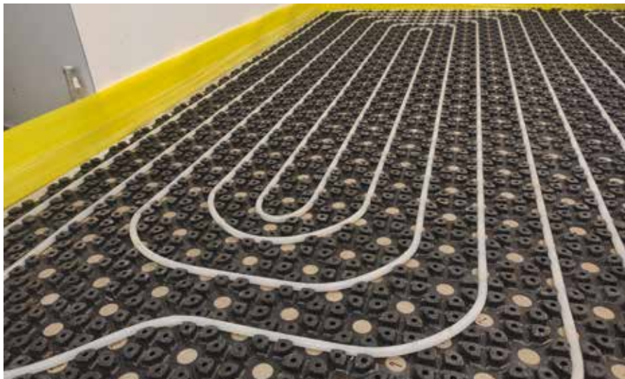
Verlegung einer Fußbodenheizung mit Eurorenova-Matte Underfloor heating instalation with usage of Eurorenova castellated mat
